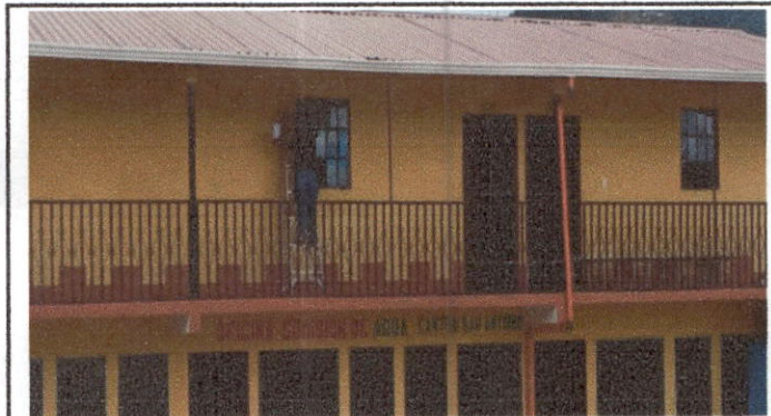
Foto 3: Sustitución de vidrios
