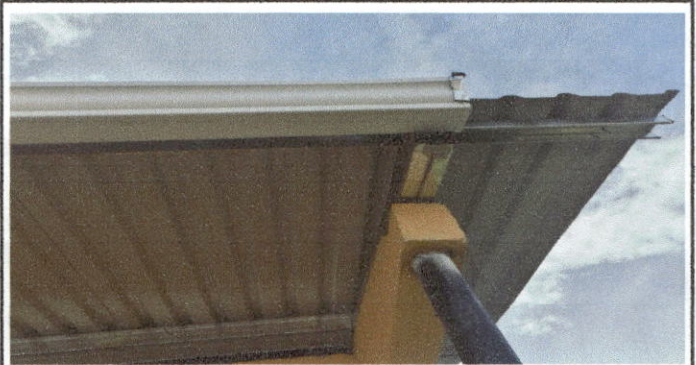
Foto 2 Sustitución de Soporte de Madera, por metal
