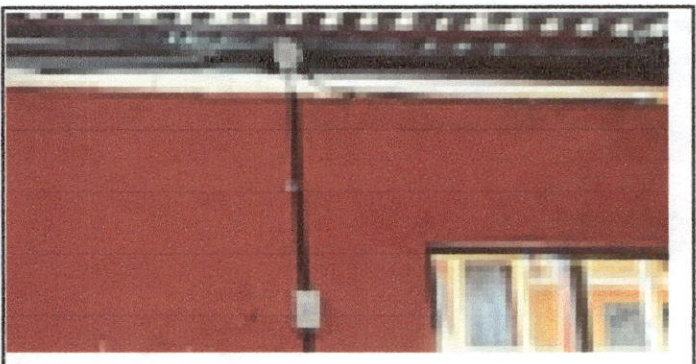
Foto 6: Reparación de cableado electrico
